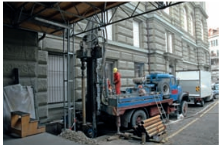
SONDIERBOHRUNGEN FÜR DEN GEPLANTEN ERWEITERUNGSBAU DER ABTEILUNG GEGENWART
