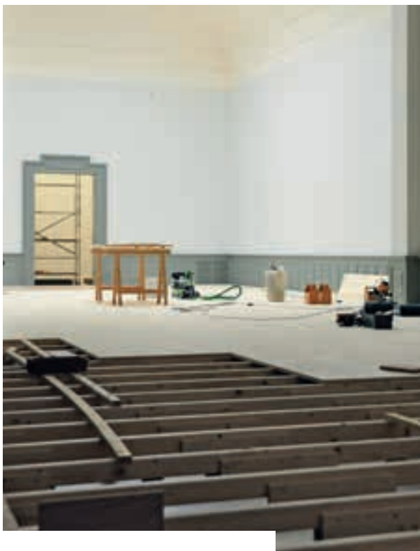
Einzug des Holzbodens im Hodler-Saal für die Ausstellung Eisen und Stahl
