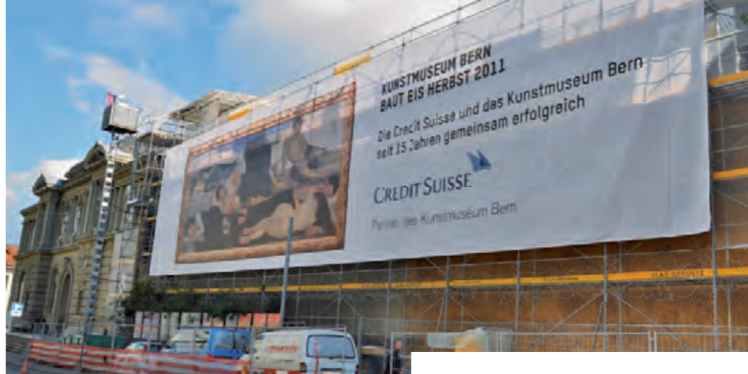
Das Big-Poster am Gerüst während der Sanierung des Flachdachs
